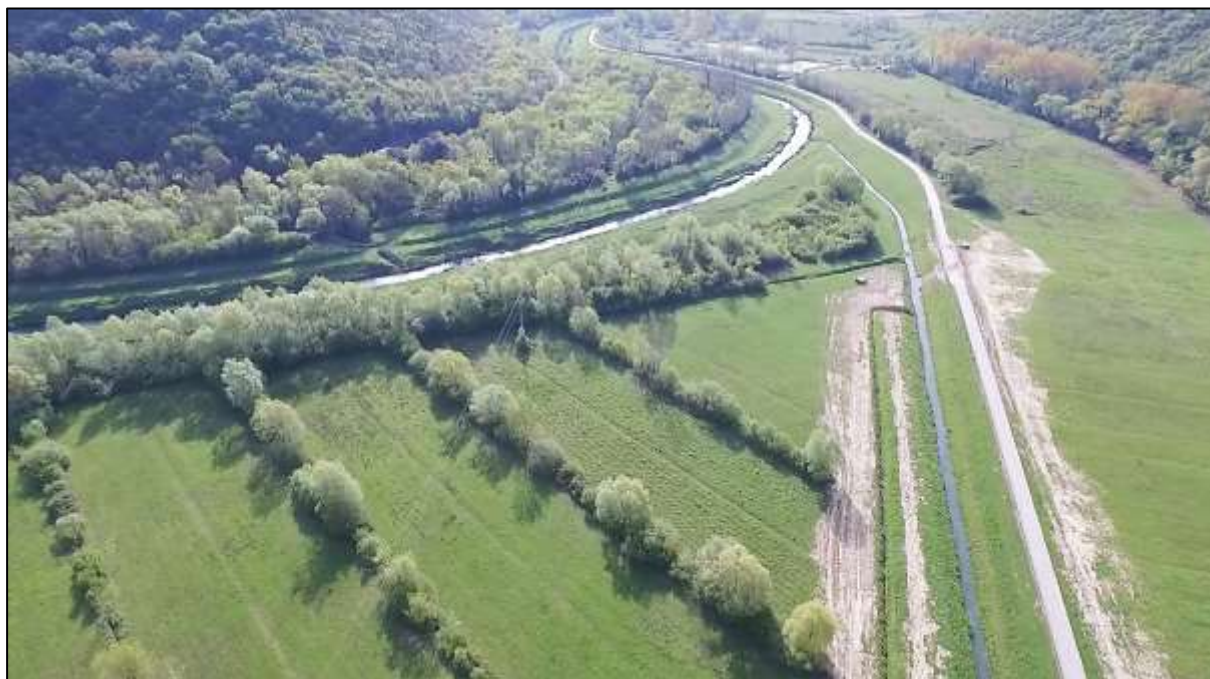
Slika 2.1.-3. Prikaz utoka potoka Rakonek u rijeku Rašu i pristupnu prometnicu izvorištu.
