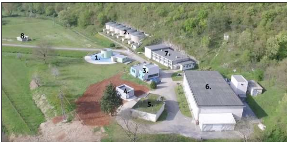
Slika 2.1.-1. objekti postrojenja za obradu vode za piće Rakonek
