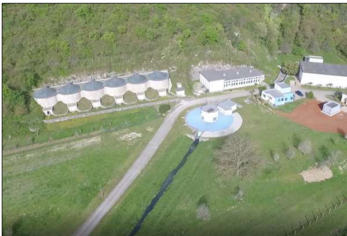
Slika 2.1.-2. Prikaz lokacije smještaja izvorišta Rakonek s vidljivim objektima (pogled s istoka).
